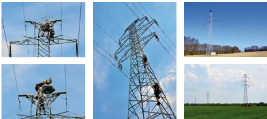
Fot. 2. Przykładowe platformy lęgowe montowane na słupach wysokiego napięcia w celu ochrony rybołowa Pandion haliaetus w województwie lubuskim
